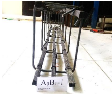
Gambar 6. Detail pemasangan tulangan.
